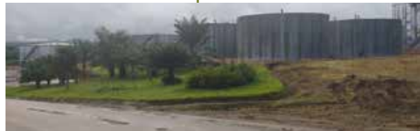
Figura 1 - Bateria de tanques para armazenamento de etanol no município de Boca da mata-AL
